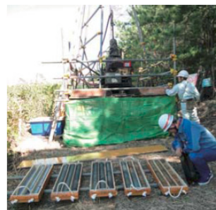
ボーリング調査
