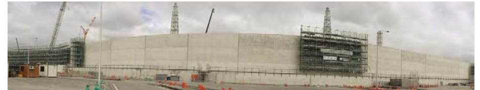
1～4号機側防潮堤
