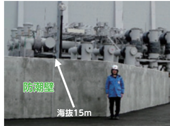
開閉所防潮壁
