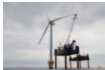
千葉県銚子市沖での風車組立の様子（10月14日）（最大出力0.24万kW）
