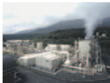
八丈島地熱発電所（東京都）
