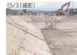
貯水池設置工事
