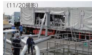
可動式熱交換器設備の試験運転
