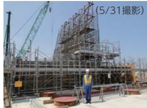
1～4号機側防潮堤（堤防）工事
