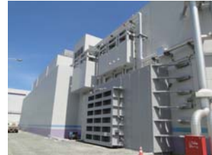
1号機防潮壁・防潮板
