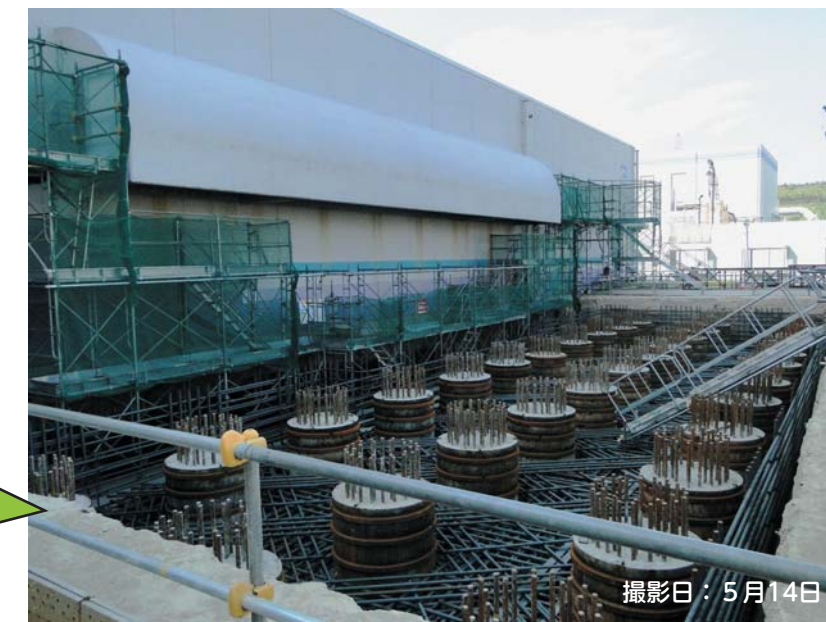
防潮壁基礎工事
