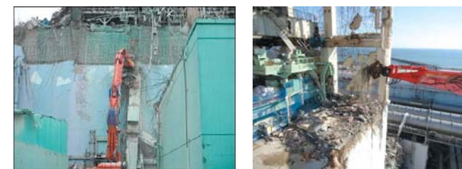
3号機がれき除去
