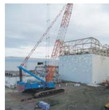
工事開始（6月28日）
