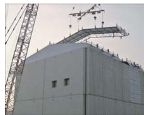
屋根パネル設置（10月14日）
