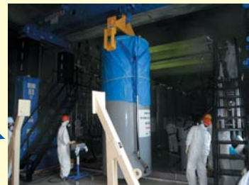
除染装置（サリー）設置工事
