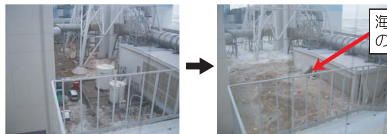
福島第一原子力発電所4号機排気筒付近の津波
