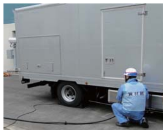
電源車へのケーブル接続
