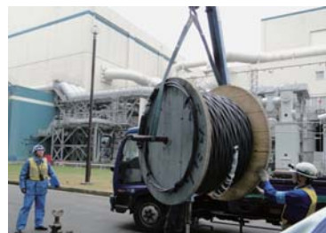
仮設ケーブルの準備
