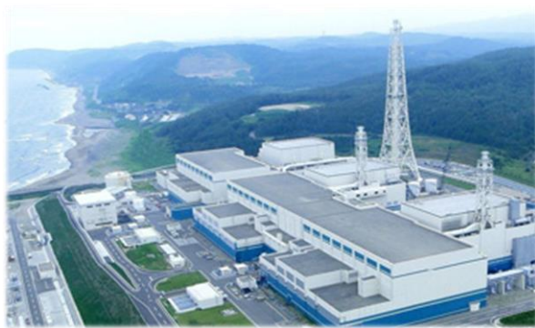
柏崎刈羽原子力発電所
