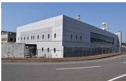
免震重要棟※(外観)
