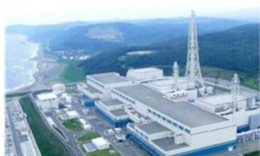
柏崎刈羽原子力発電所
