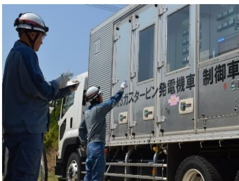
電源供給訓練
