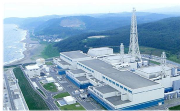
柏崎刈羽原子力発電所
