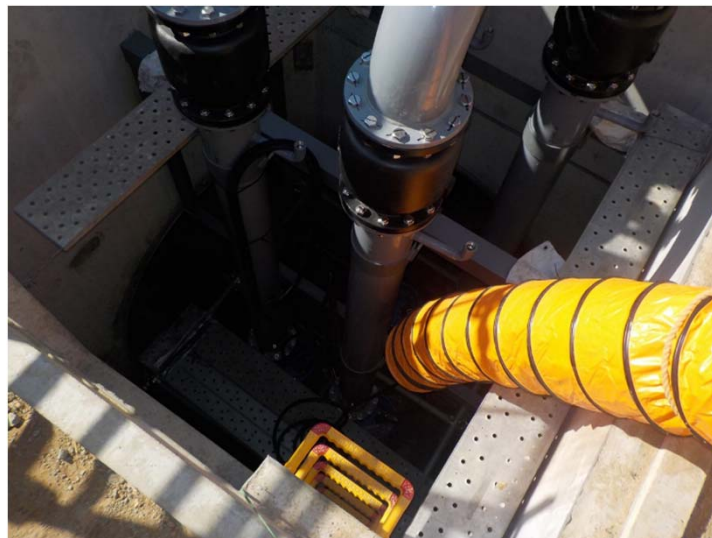
写真 地下水BPエリア枝排水路ポンプ(4台)設置状況
