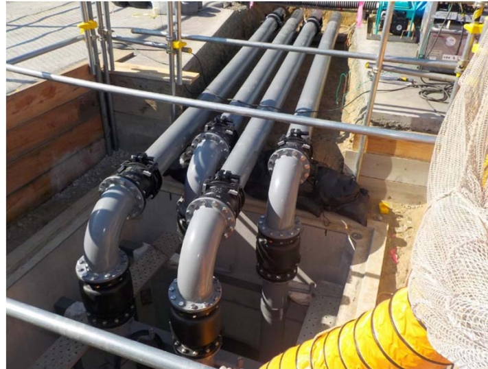
写真 地下水BP→B排水路への移送配管設置状況
