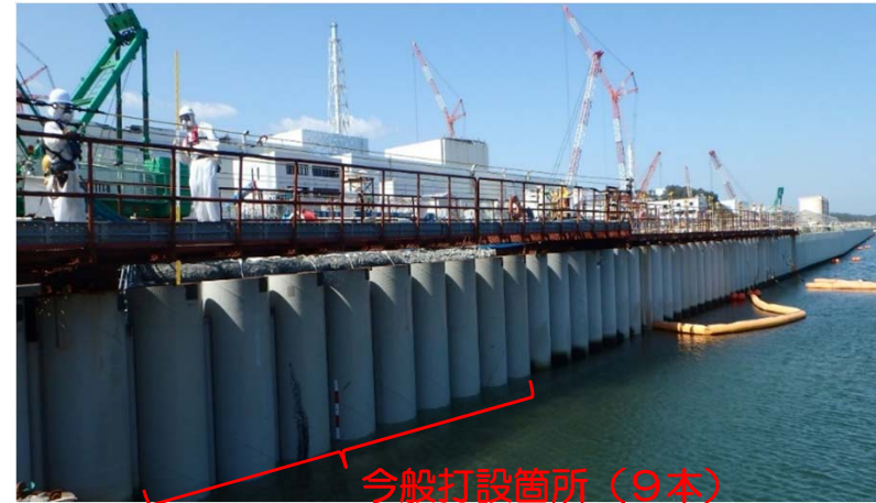
<鋼管矢板打設完了後>
