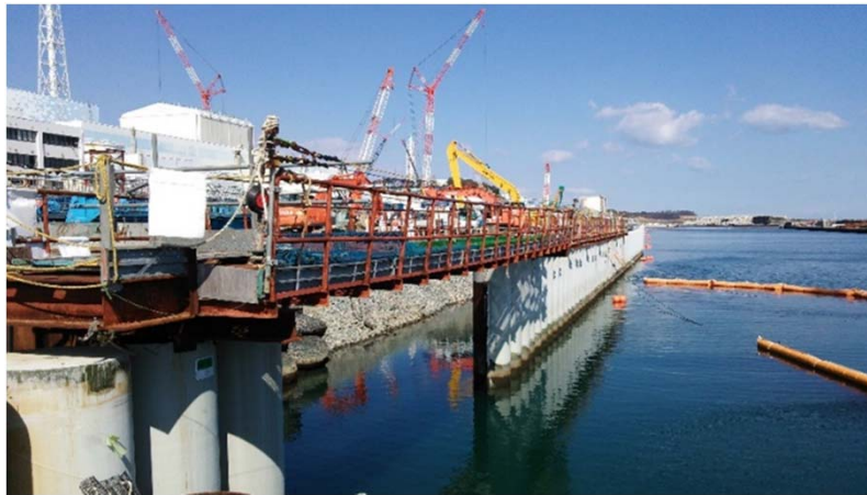
<鋼管矢板打設前>
