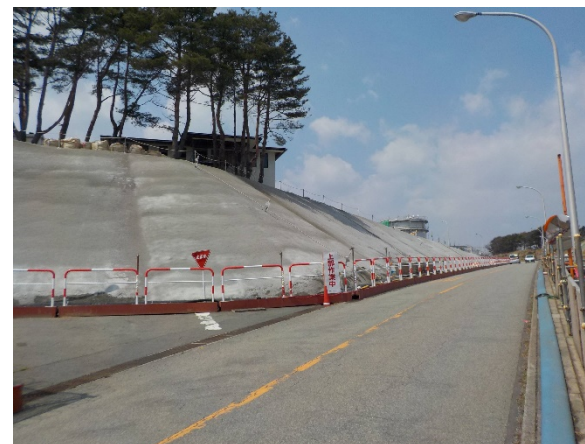
現場状況写真（写真①）
