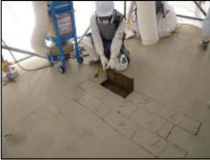
【写真⑤】汚染源撤去開始（3月30日）
