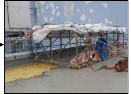
【写真⑧】仮設テント盛替状況（4月1日）
