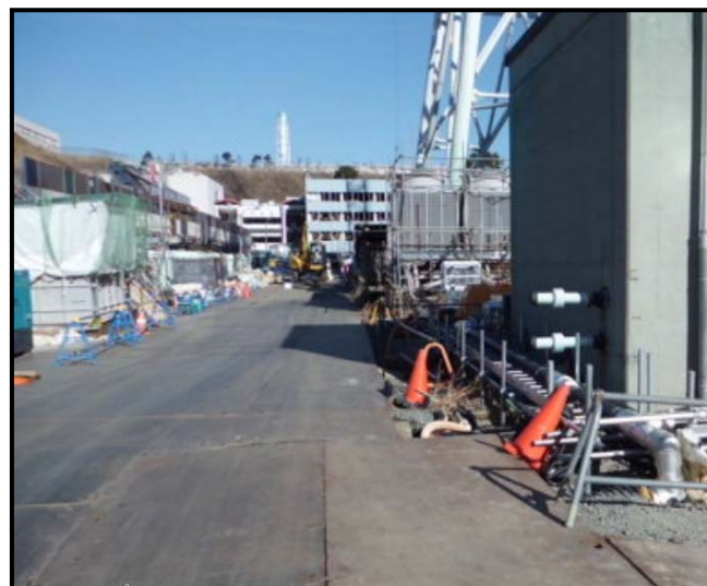
現場状況写真
