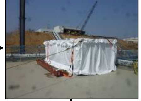
【写真④】仮設テント設置完了（3月31日）
