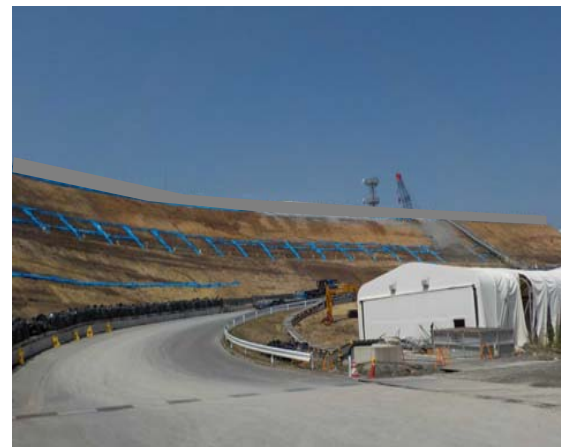
現場状況写真（写真①）
