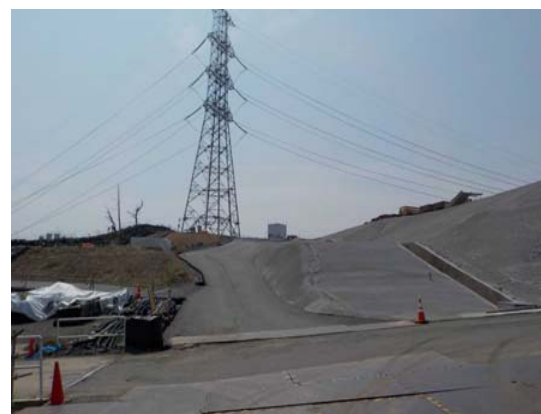
現場状況写真（写真①）
