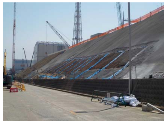
現場状況写真（写真①）
