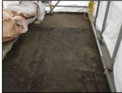
【写真⑥】仮設テント内ルーフブロック・敷砂撤去状況（3月31日）
