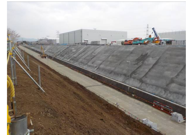
現場状況写真（写真②）
