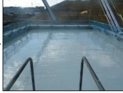
【写真③】ウレタン防水完了（3月14日）
