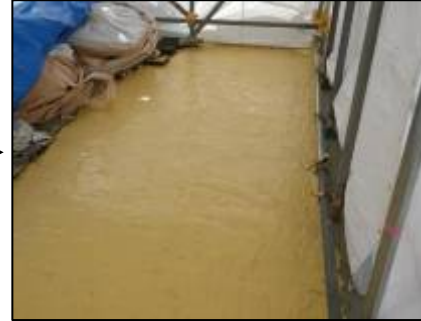
【写真⑦】仮設テント内ストリップابلペイント塗布状況（3月31日）
