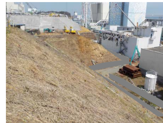
現場状況写真（写真②）
