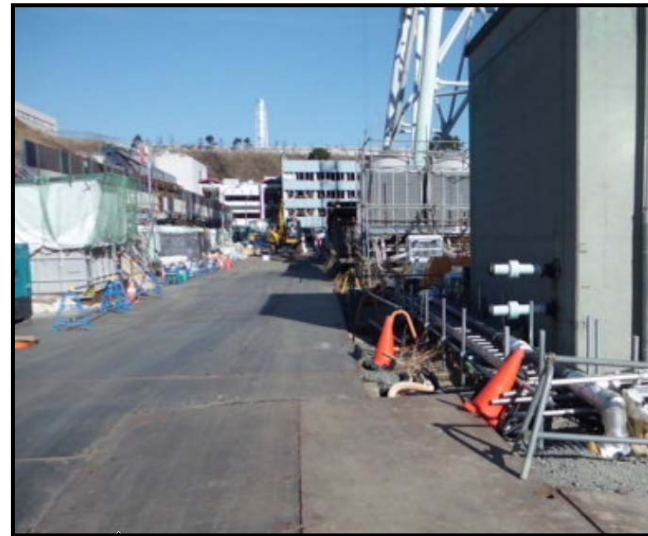
現場状況写真
