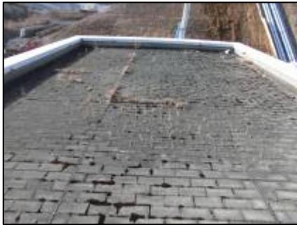
【写真①】作業前
