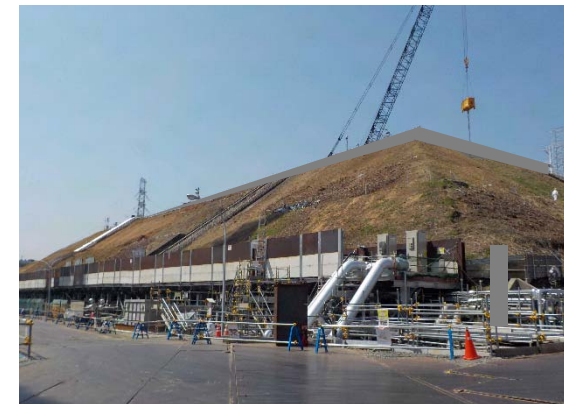
現場状況写真（写真②）
