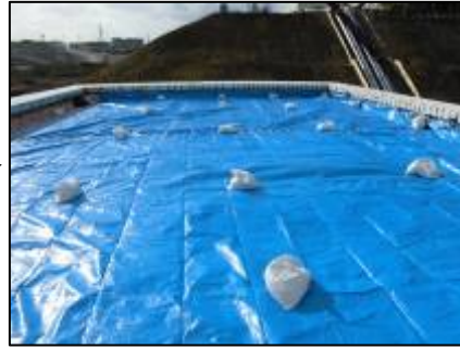
【写真②】ブルーシート設置（3月2日）
