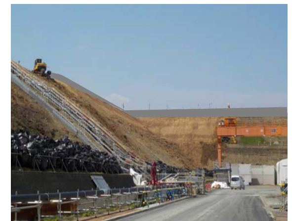
現場状況写真（写真②）
