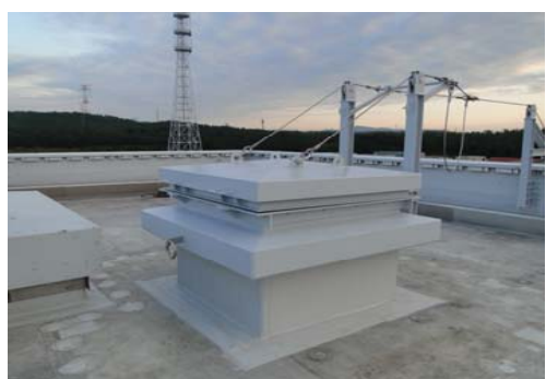
原子炉建屋トップベント設備の設置
