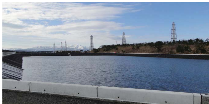
貯水池の設置
