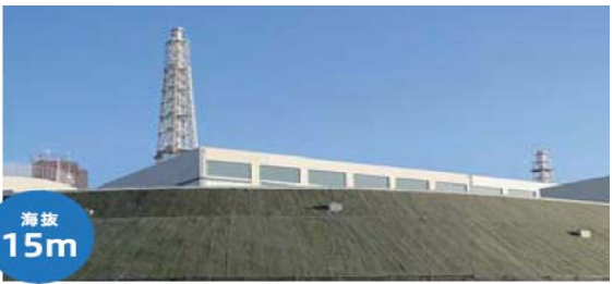
5~7号機側に盛土の防潮堤を建設
