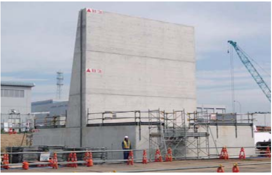
1~4号機側に防潮堤を建設
