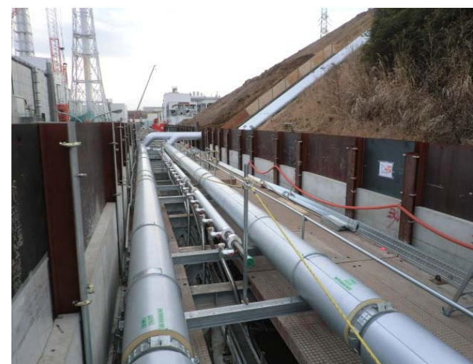
写真③：5BLKブライン配管設置状況
