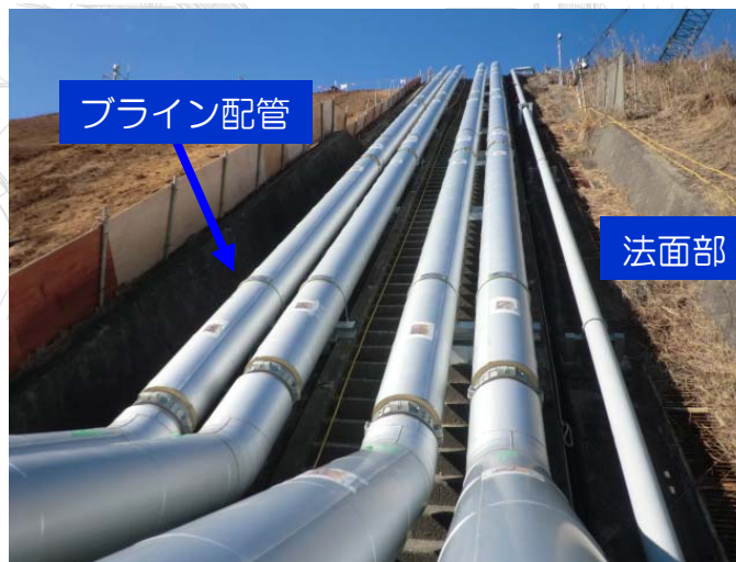
写真②：法面部ブライン配管設置状況
