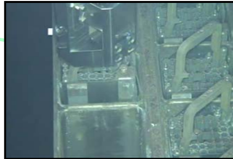
②燃料を掴みラックから引き上げ (撮影日:平成25年11月20日)
