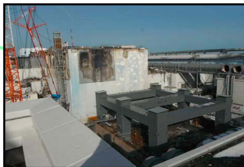
②第一節 鉄骨建方完了 (撮影日:平成25年1月14日)
