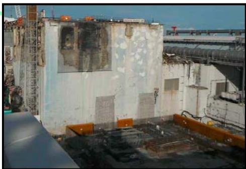
①鉄骨建方着工前 (撮影日:平成24年12月18日)
