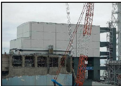
⑦外壁・屋根パネル設置完了 (撮影日:平成25年7月20日)
