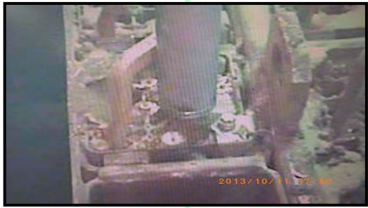
②燃料ラック上部ガレキ吸引作業 (撮影日:平成25年10月11日)
