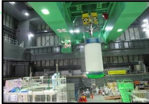
①キャスクを使用済燃料プールへ移動 (撮影日:平成25年11月18日)
