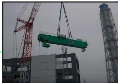
⑤天井クレーン部材吊り上げ (撮影日:平成25年6月7日)
