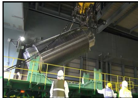
⑥トレーラーへの積み込み (撮影日:平成25年11月21日)
