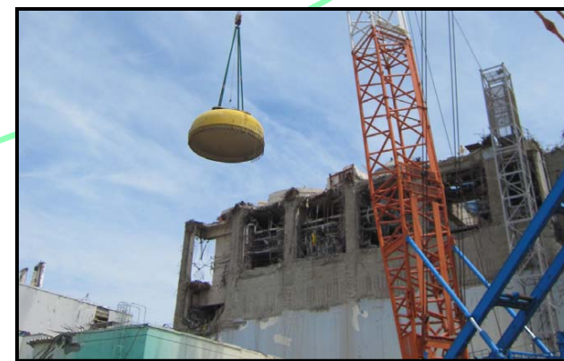
④格納容器上蓋の撤去 (撮影日:平成24年8月10日)
