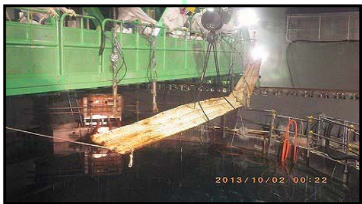
①大型ガレキの撤去 (撮影日:平成25年10月2日)
