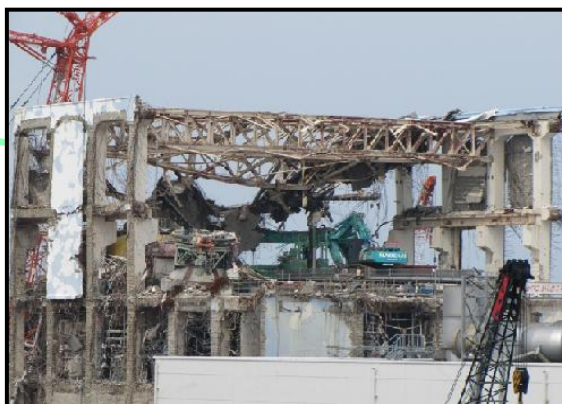
②撤去作業中の様子 (撮影日:平成24年5月28日)
