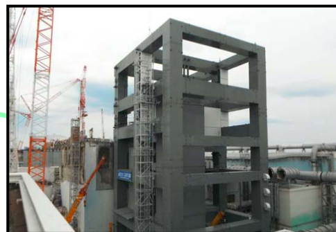
③原子炉建屋上部を除く鉄骨建方完了 (撮影日:平成25年4月10日)
