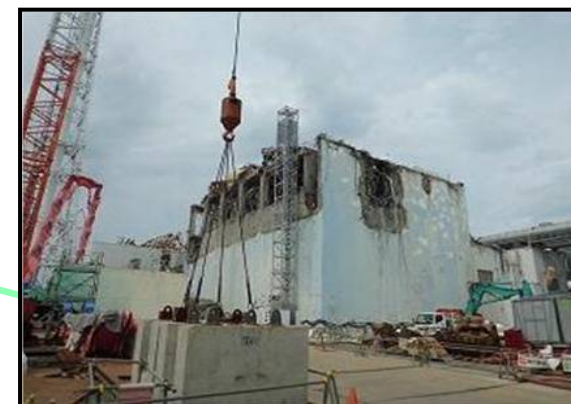
③撤去作業終了後 (撮影日:平成24年7月5日)
