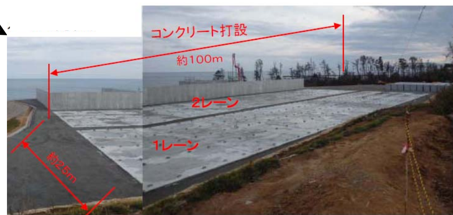
コンテナ基礎(エリアP)
