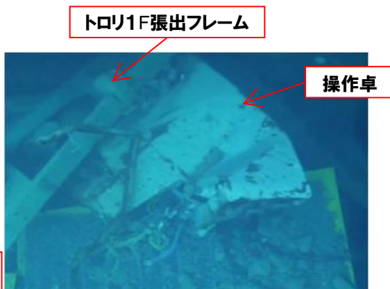
操作卓 トロリ1F張出フレーム
