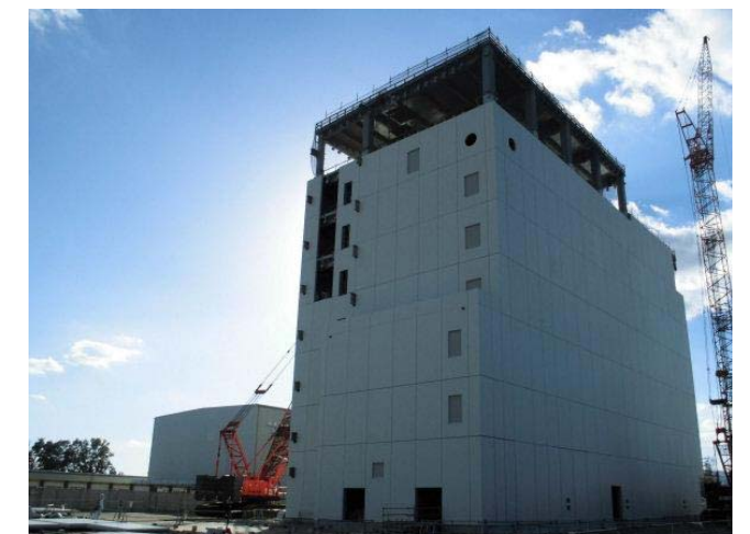
大型休憩所建設状況 平成26年11月時点
