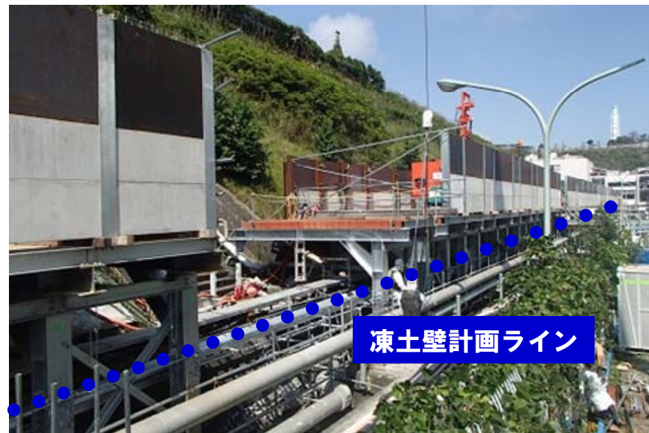
構台およびコンクリートパネル設置
