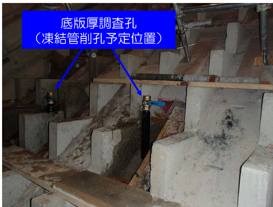
電気洞道内部状況
