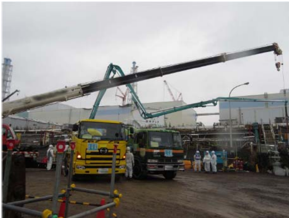
充填作業状況
