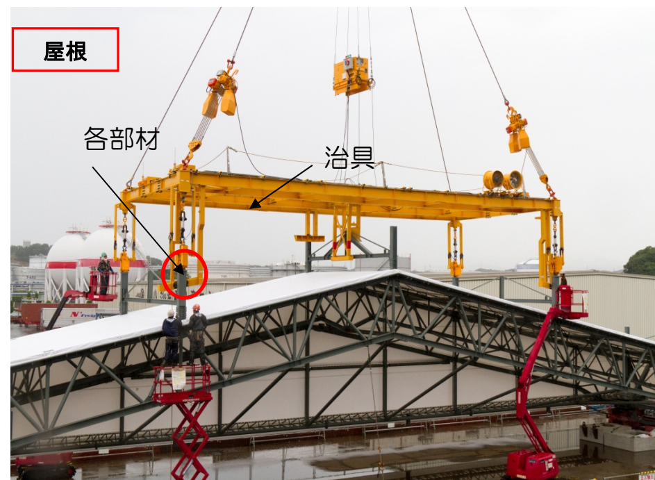
屋根パネル吊り状況（モックアップ時）
