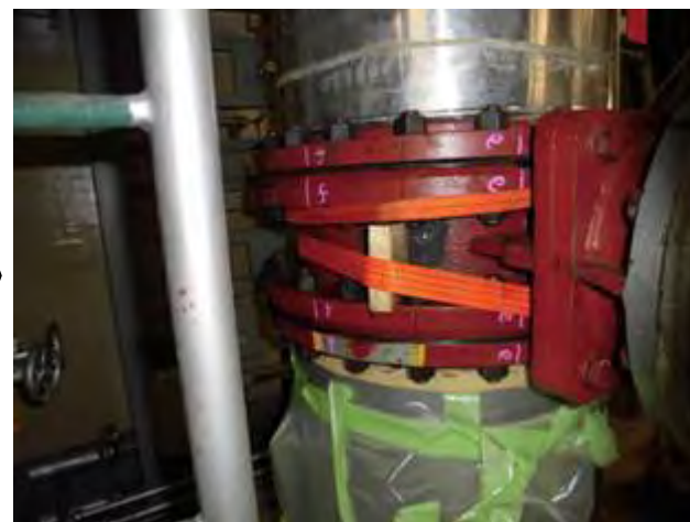
91B弁応急処置状況
