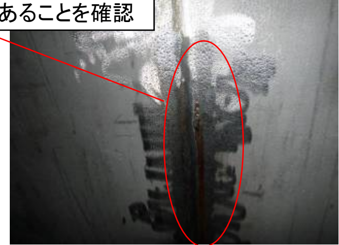
①タンク下部状況 (拡大)
