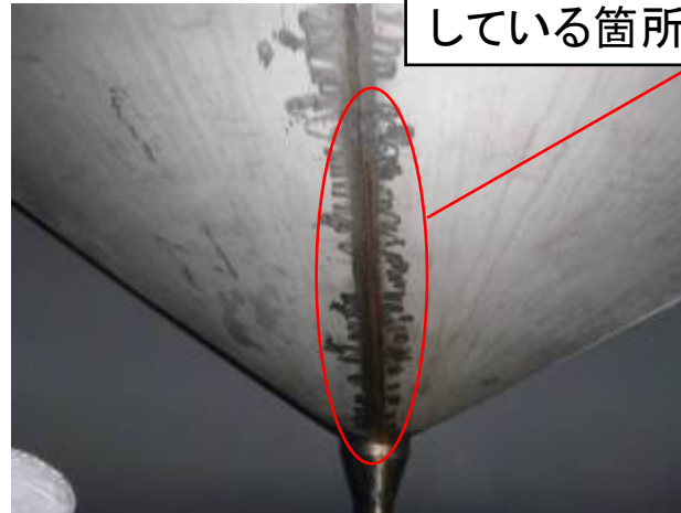
①タンク下部状況
