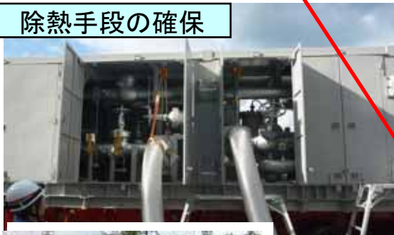
代替高圧注水設備設置
