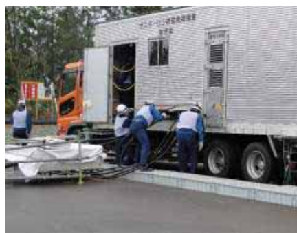
GTGによる電源供給訓練
