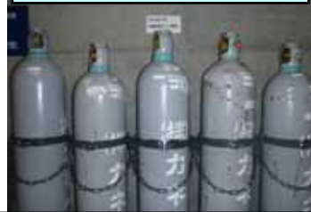
予備ポンベの配備
