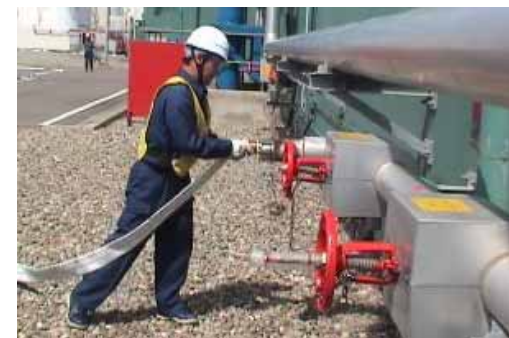
消防車による注水訓練
