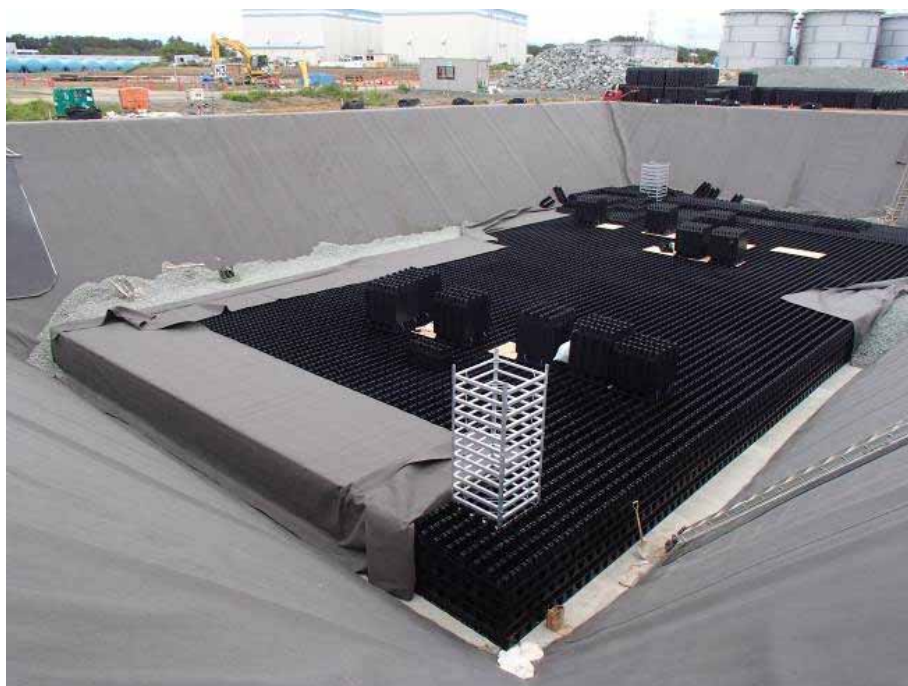
【貯水材組立状況】
