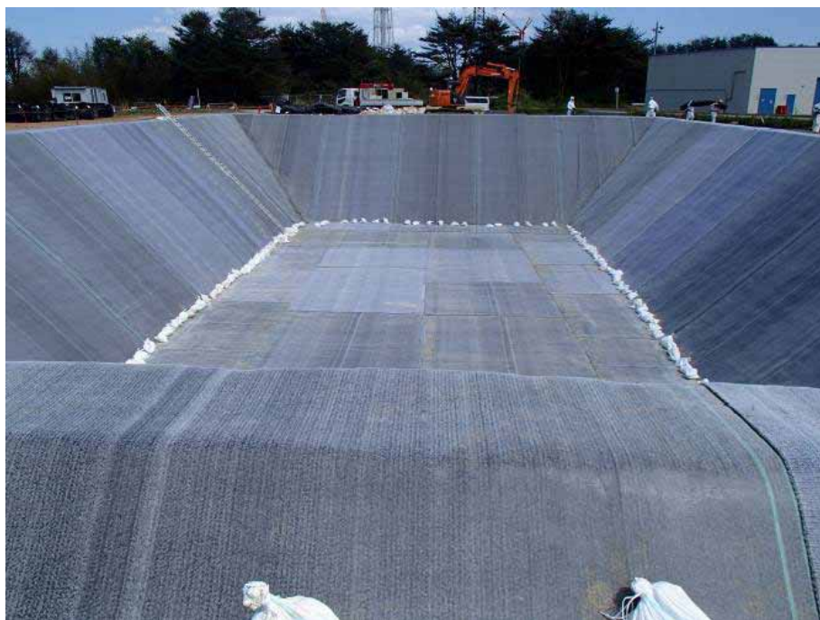
【ベントナイトシート敷設完了】
