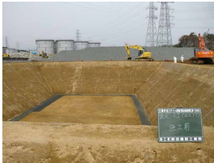
【掘削・地盤改良完了】
