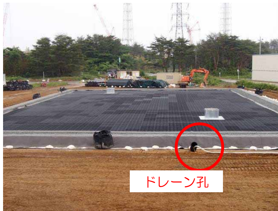
【貯水材組立完了】
