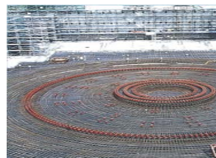
原子炉建屋基礎版の鉄筋組立
