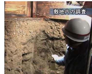
敷地内立坑調査
