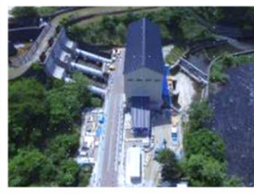
日橋川発電所 最大出力：11,000kW 運転開始：2021年7月
