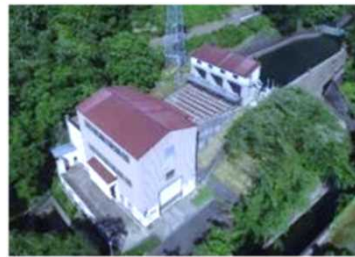
金川発電所 最大出力：7,100kW 運転開始：2019年10月
