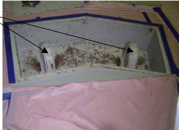
原子炉ウェルカバー吊り上げ金具収納部(類似箇所写真)
