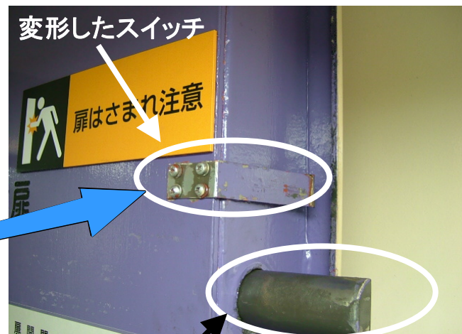
当時、正常な位置にロックされていなかったカンヌキ
