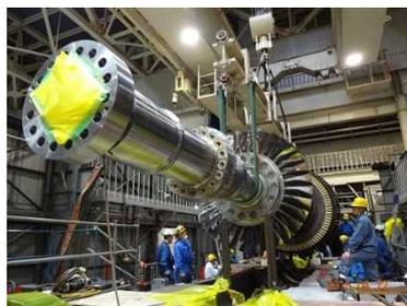
新しいガスタービン設備（ローター）の吊り込み作業
