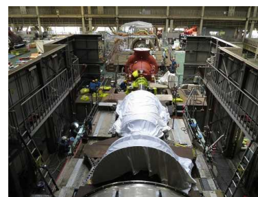
ガスタービン設備分解作業
