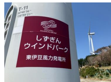
本発電所内の様子
