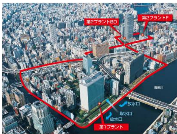
写真2 箱崎地区全景（赤枠内の11件のオフィスビルと集合住宅に対して空調・給湯用の熱を供給）
