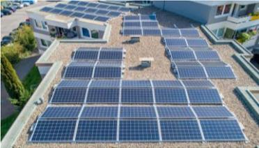
傾斜のない平面な屋根に設置する形態
