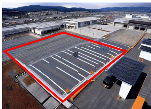
【ソーラーカーポートの設置】
