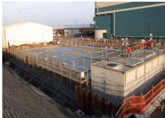
<After concrete pouring>
