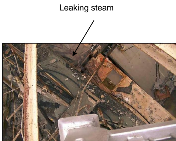
撮影者：東京電力株式会社 撮影日：平成23年8月24日
