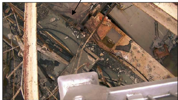
撮影者: 東京電力株式会社 撮影日: 平成23年8月24日
