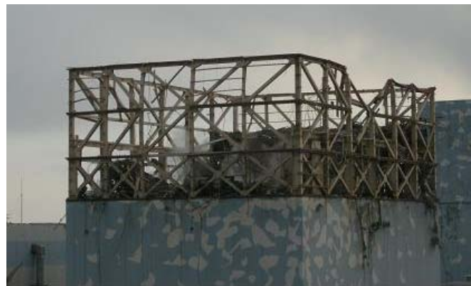
図 1号機原子炉建屋の外観写真
