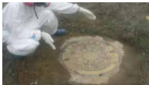
FP tank manhole
