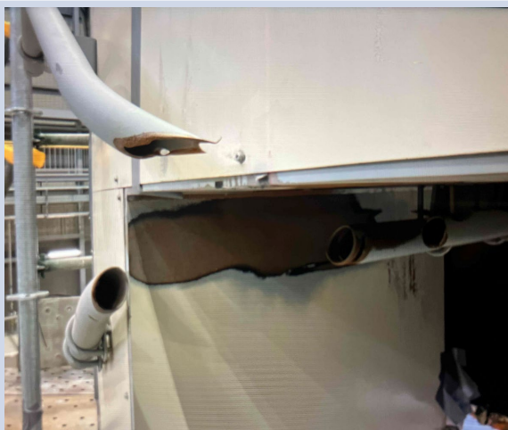
Electrical conduit removal(C)
