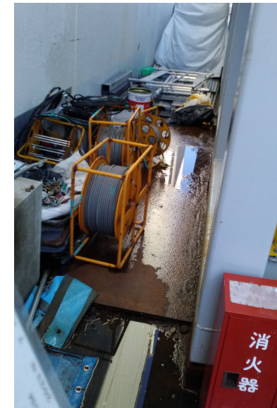
【Metal plates laid on the ground】
