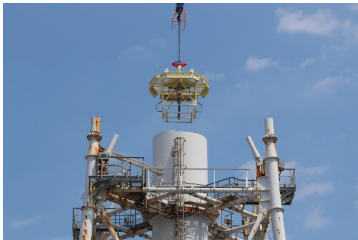
<Installing the lid>
