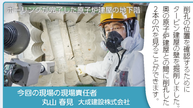
▲ 水を使わずに削孔するため、 先端部の消耗品は約1.6mの 掘削で1日1回取替 (汚染水を発生させない観点)
