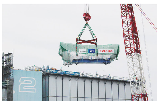
クレーンにより、2号機の燃料取り出し用構台へ搬入される燃料取扱設備の様子(5月30日撮影)
