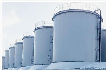
福島第一原子力発電所では、ほとんど解体が完了しているフランジ型タンクのあるEエリアやALPS処理水の海洋放出等により空いたJ8\*・J9エリアの溶接型タンクを解体し、燃料デブリ取り出し関連施設を設置することにより、廃炉を進めていきます。
