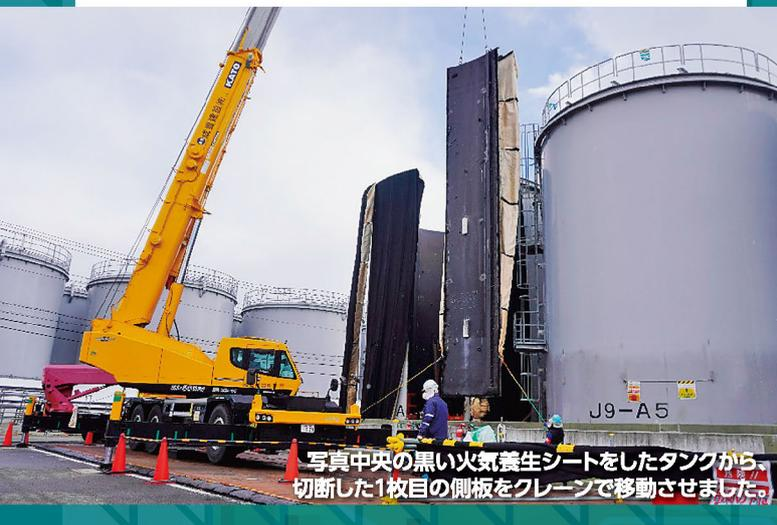
写真中央の黒い火気養生シートをしたタンクから、切断した1枚目の側板をクレーンで移動させました。
