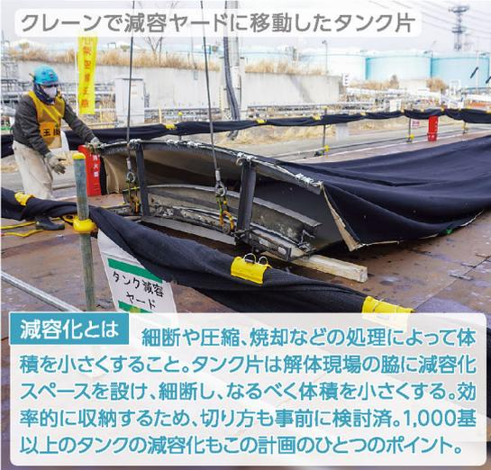
**減容化とは** 細断や圧縮、焼却などの処理によって体積を小さくすること。タンク片は解体現場の脇に減容化スペースを設け、細断し、なるべく体積を小さくする。効率的に収納するため、切り方も事前に検討済。1,000基以上のタンクの減容化もこの計画のひとつのポイント。
